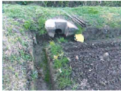
【周田溝と排水溝をつなげた圃場】
